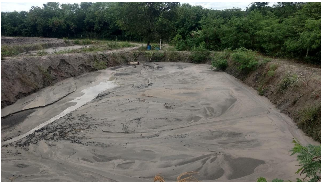
Figura 7: Bacia de sedimentação. Presença dos rejeitos, aguardando secagem para ser removido. Fonte: Fotos do autor.
